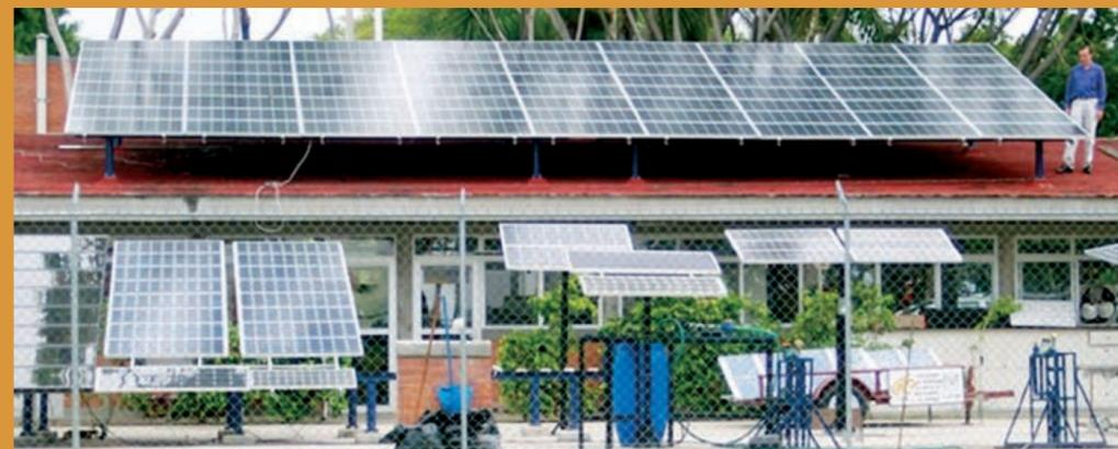
Los paneles fotovoltaicos, compuestos por miles de pequeñas celdas solares, captan la energía del astro para generar electricidad, pero en la noche son inútiles; de ahí la necesidad de un sistema híbrido.
