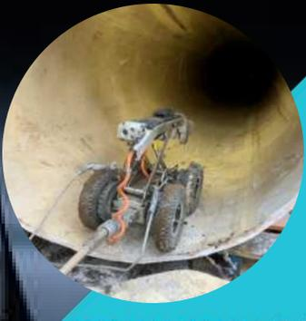
Los pasos que se siguen en la instalación de los materiales son videoinspección, fabricación de la tubería, instalación y curado, inspección final, pruebas de tensión y flexión; todos estos procesos están certificados y avalados por la UNAM.
